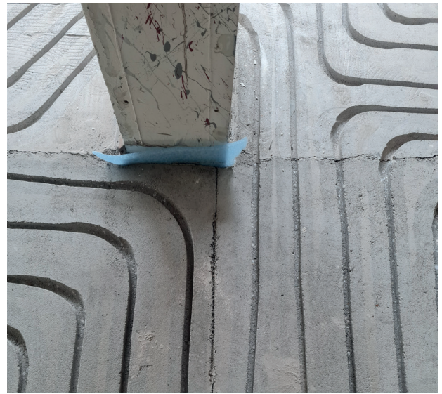
Anarbeiten einer Säule mit Fugen im Estrich
