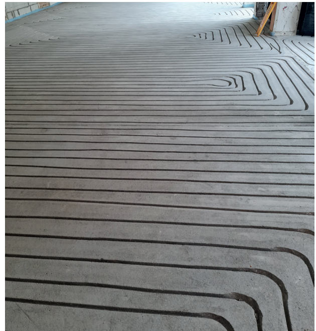
Flächenbild Estrich mit Schlitzen für das Einlegen der Heizungsrohre
