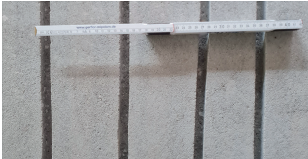
Unterschiedlich breite Einfürungen im Estrich
